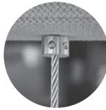
Unter dem Paneel angebrachte Kabelklemme zur Höheneinstellung
